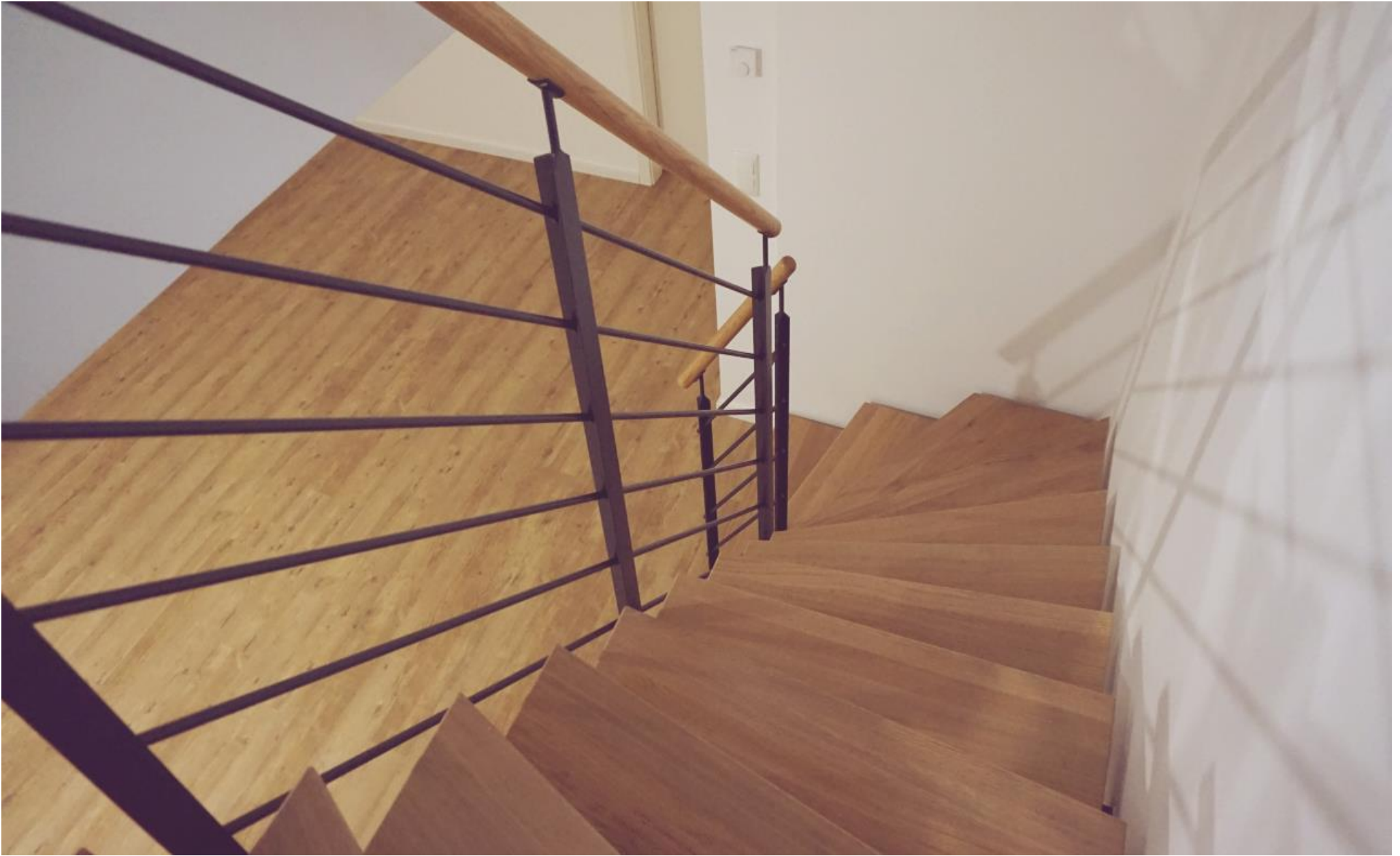
Beispiel einer durch Krebs Treppen verbaute Zweiholm-Treppe in der Vogelzeile 3 nach Übergabe.
